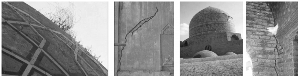
نمونه‌هایی از ترک‌ها در مسجد جامع ساوه
